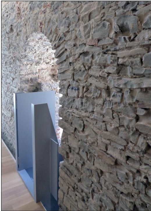
De toegangspoort tot de donjon in de huidige donjonwoning. (Foto: Hugo Schaeck)
